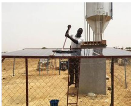
Figure 1 - Intervention de nettoyage des modules photovoltaïques sur le démonstrateur.
